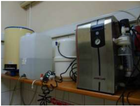
Instalacja wody dejonizowanej
