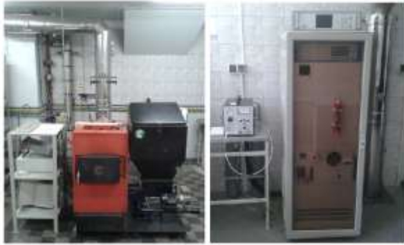
3. Stanowisko do badania procesów spalania węgla i biomasy w kotłach małej z zestawem analizatorów
