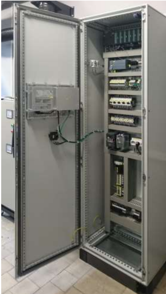
Instalacja w laboratorium:
