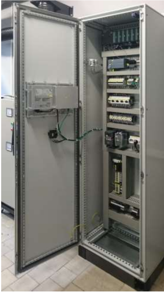
Instalacja w laboratorium:
